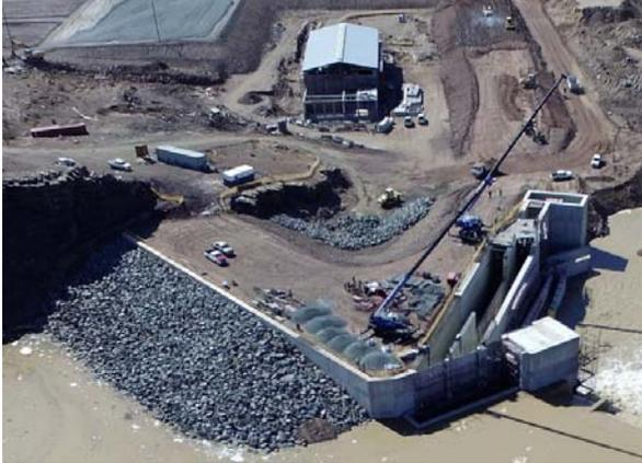
*Fig. 6. Neckartal Dam: Sediment trap.*
