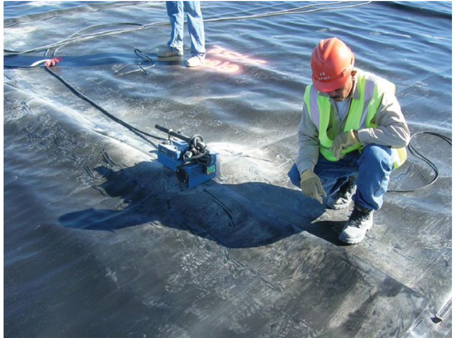
Wedge welding an HDPE geomembrane.
